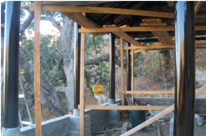
Dựng nhà rường tại Pháp Chủ Thiền Viện 7-2010.
