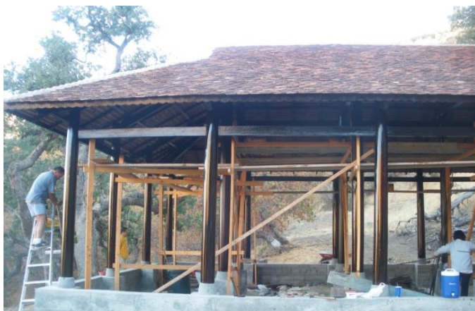
Dựng nhà ruộng tại Pháp Chủ Thiền Viện 7-2010.
