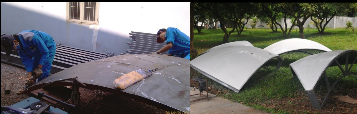
La couverture de la dôme en cours de réalisation.
