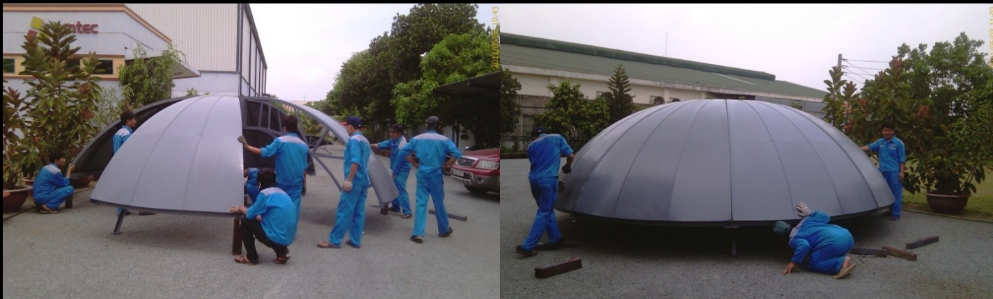
La structure en métal et sa couvercle en cours de montage.
