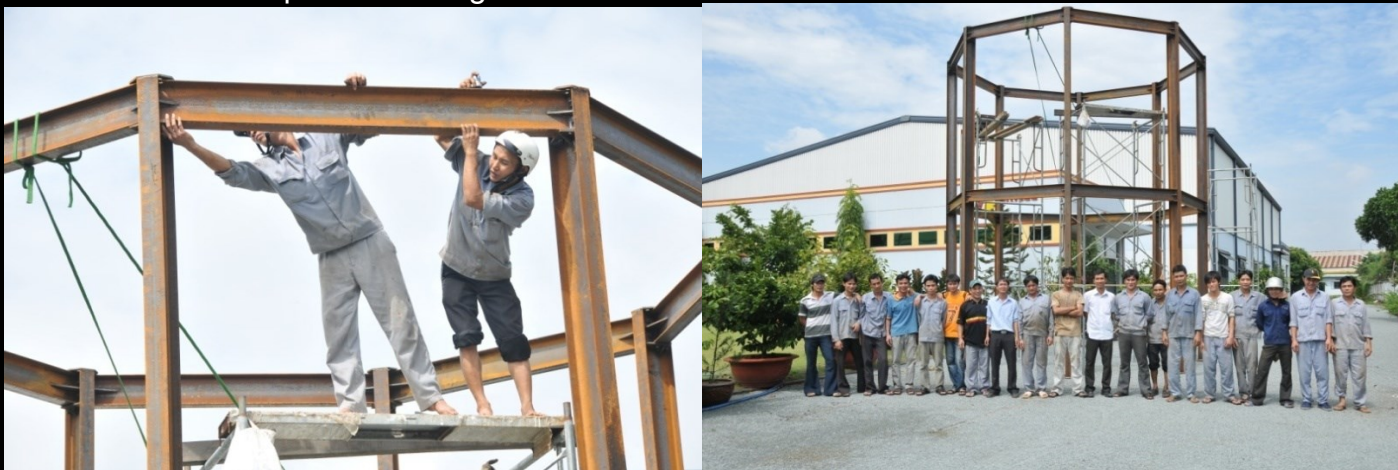
La structure métallique en montage d'essai.
